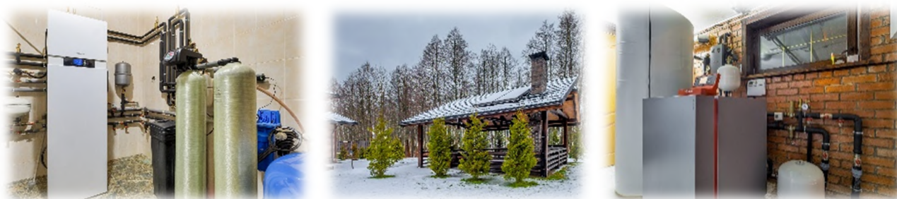
Тепловой насос и солнечные панели для обогрева жилых помещений в туристическом комплексе «Green Club», Брагский р-н, Минская область.
