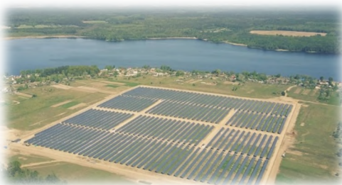
Солнечная электростанция 11.4 МВт Чечевичи, Могилевская область
